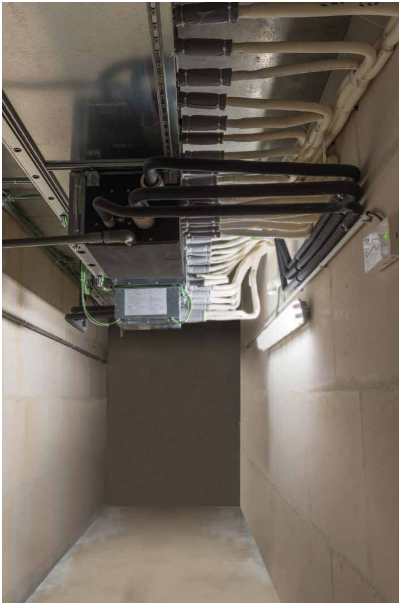
Установка окремих або мульти блоків-розподільників
