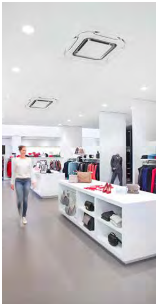
Круглопотоковый касетный блок
