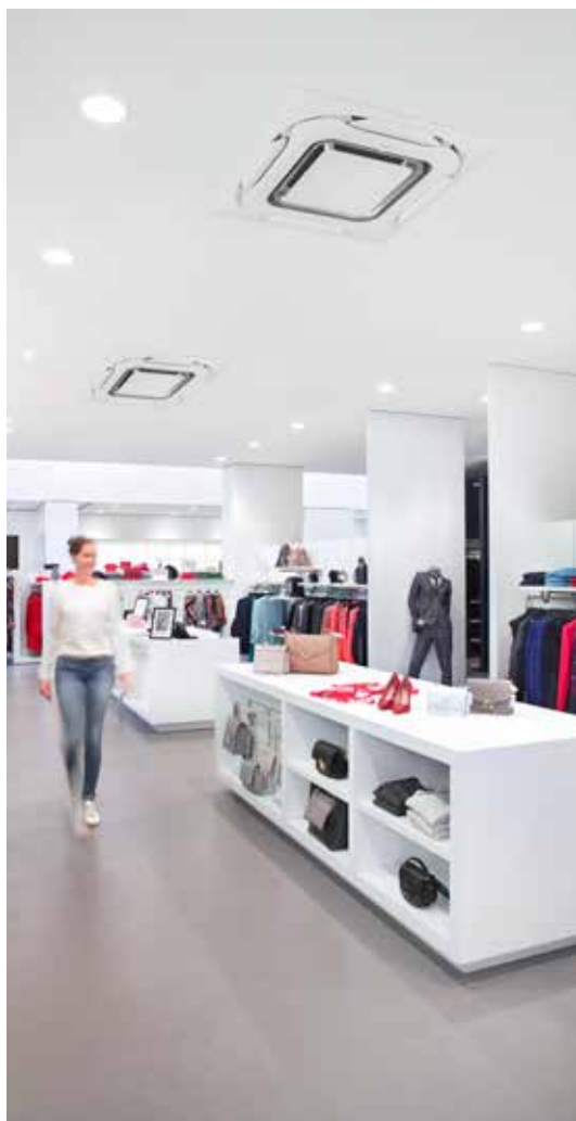
Круглопотоковый касетный блок
